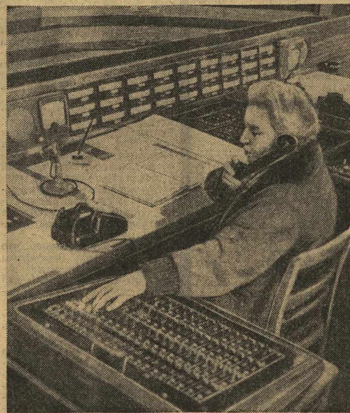
Этот снимок сделан на центральном пульте в Пермэнерго. Старший диспетчер З. Ф. Яковлева управляет энергетикой всей области, электростанции которой являются частью единой Европейской энергосистемы страны.
