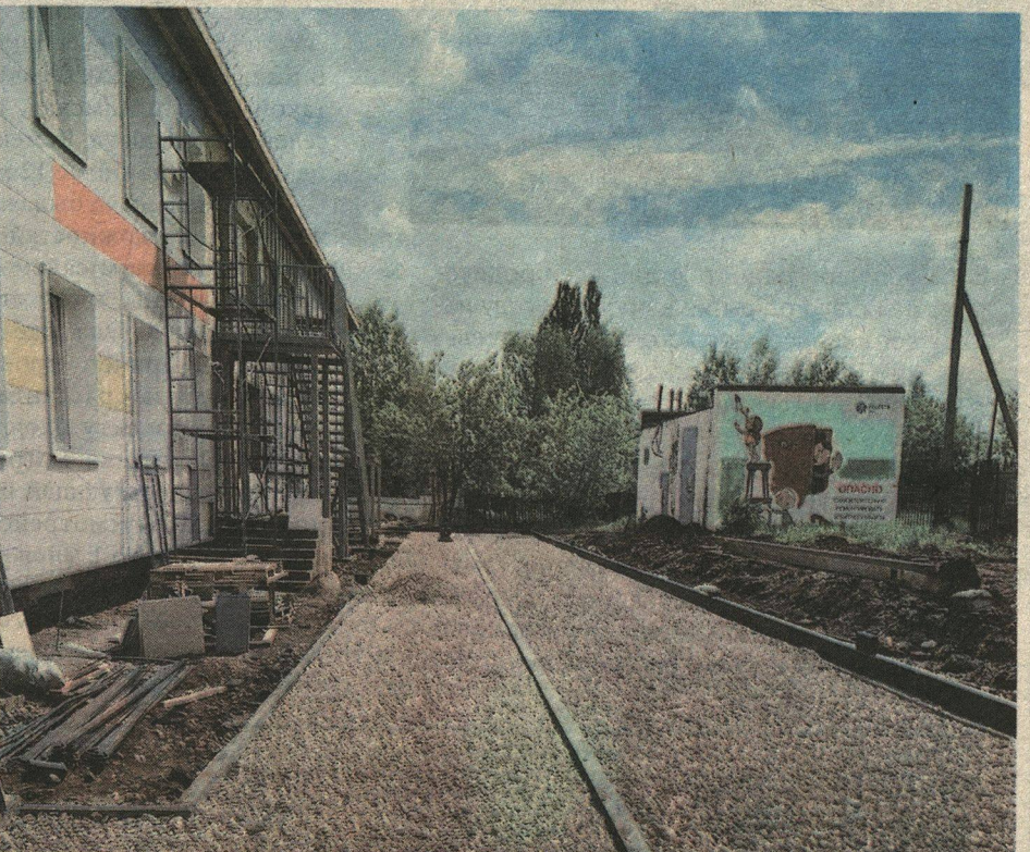
Строительство детского сада во Фролах
