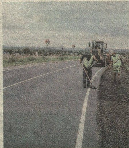
Ремонт дорог в Гамовском поселении
