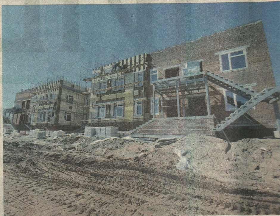
Строительство детского сада в Ясырках
